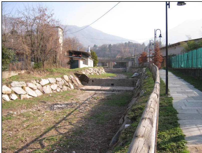
Figura 4.11: Tratto terminale del T. Muceno. Si notano le opere idrauliche trasversali (briglie) e gli interventi di sistemazione idraulica longitudinale.
