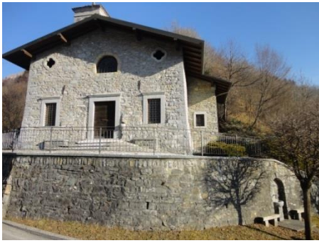
La chiesa di S. Rocco come appare dopo il restauro del 1991 -
