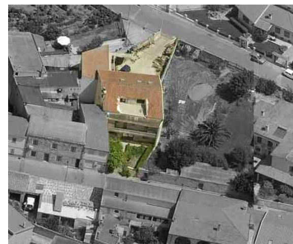
C 12 - U.E. 23 Criticità tipologica - volumetrica - architettonica
