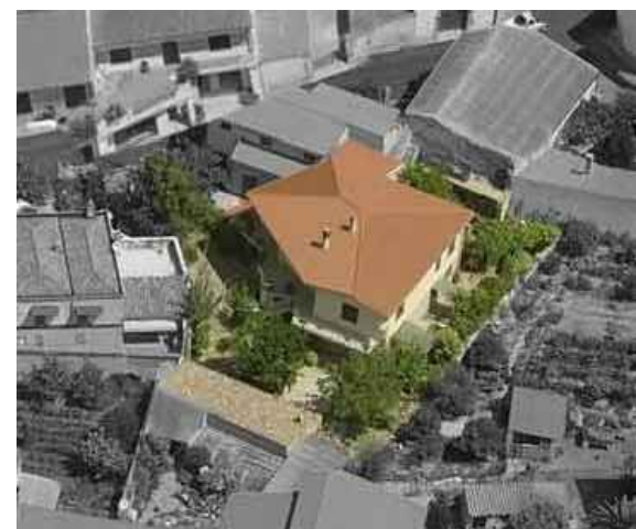
C 12 - U.E. 15 Criticità tipologica - volumetrica - architettonica
