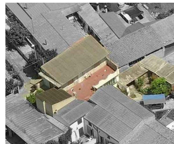
C 13 - U.E. 17 Criticità tipologica - volumetrica - architettonica
