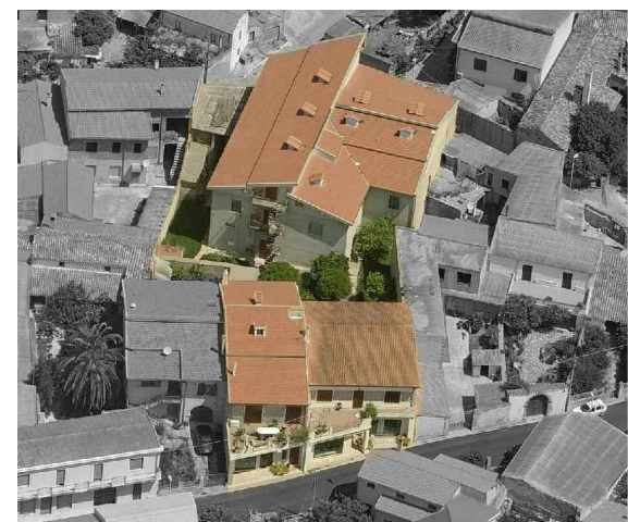
C 1 - U.E. 39 Criticità tipologica - volumetrica - architettonica
