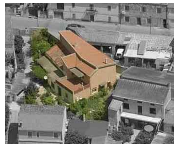
C 5 - U.E. 12 Criticità tipologica - volumetrica - architettonica
