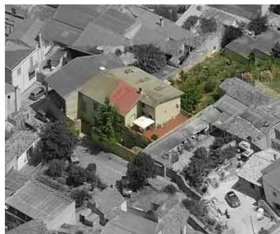
C 5 - U.E. 1 Criticità volumetrica - architettonica
