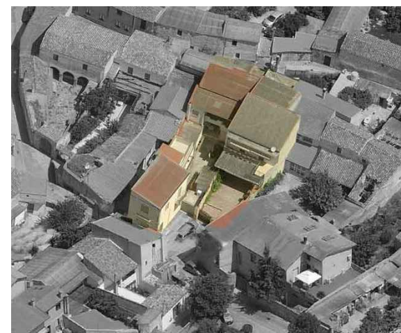
C 4 - U.E. 28-29 Criticità architettonica
