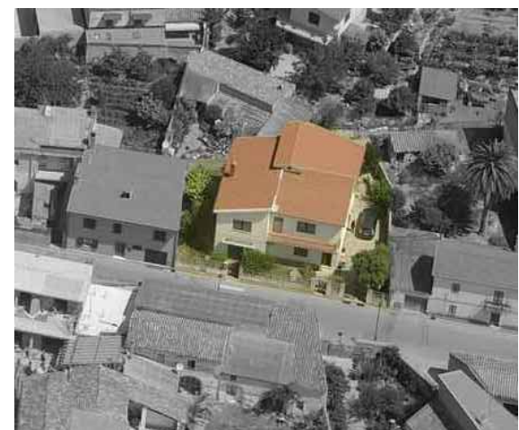
C 12 - U.E. 18 Criticità tipologica - volumetrica - architettonica
