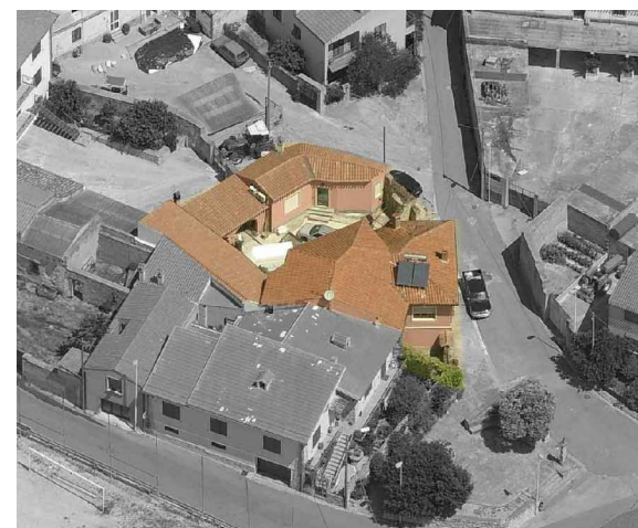
C 8 - U.E. 9 Criticità architettonica
