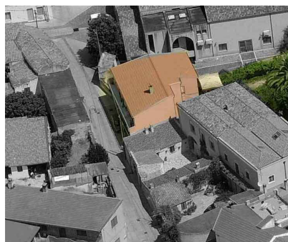
C 3 - U.E. 4 Criticità tipologica - volumetrica - architettonica
