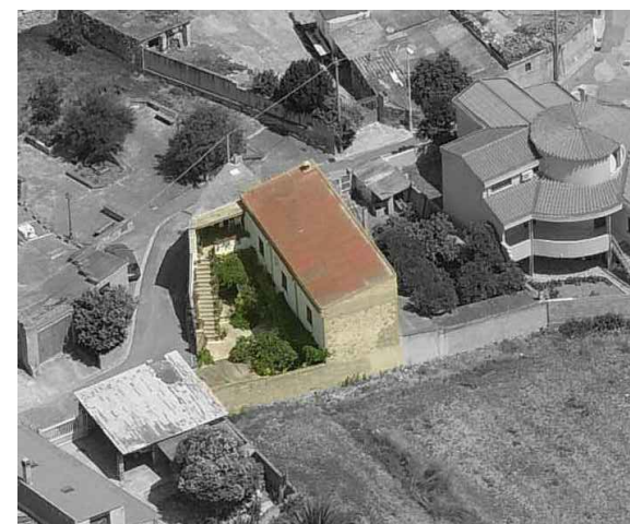
C 13 - U.E. 11 Criticità architettonica
