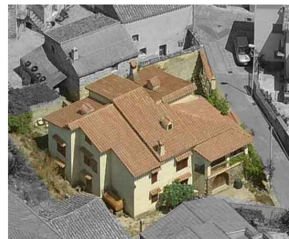
C 8 - U.E. 5 Criticità tipologica - volumetrica - architettonica
