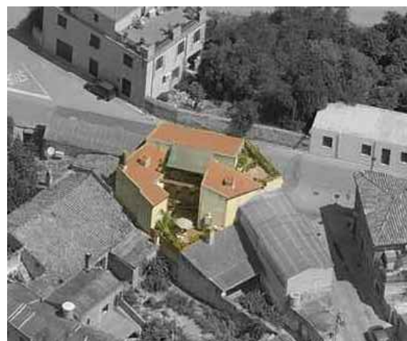
C 4 - U.E. 3 Criticità tipologica - volumetrica - architettonica
