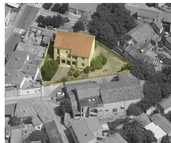
C 3 - U.E. 2 Criticità volumetrica - architettonica
