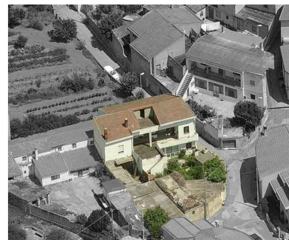
C 13 - U.E. 6 Criticità volumetrica - architettonica
