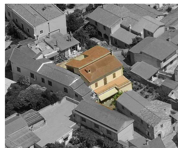
C 3 - U.E. 19 Criticità volumetrica - architettonica
