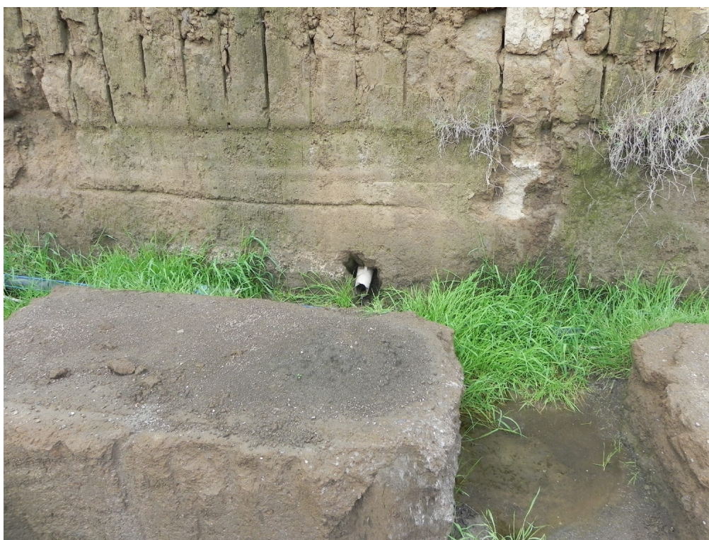
Foto 6) – Affioramento della falda al fronte dello scavo con foro di drenaggio per raccolta d'acqua
