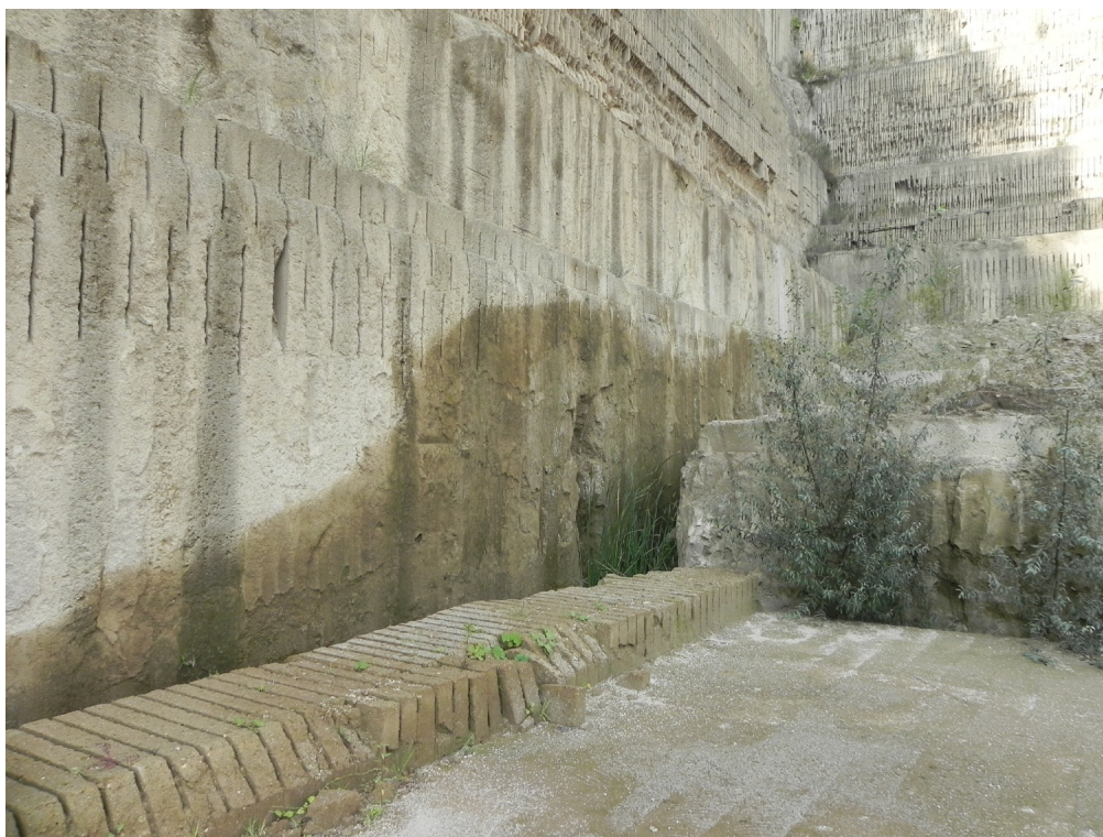
Foto 5) – Affioramento della falda sul fronte dello scavo
