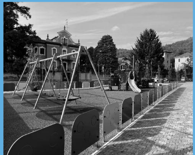
La nuova recinzione messa in opera al parco giochi inclusivo di via Crugnola, davanti alla stazione
