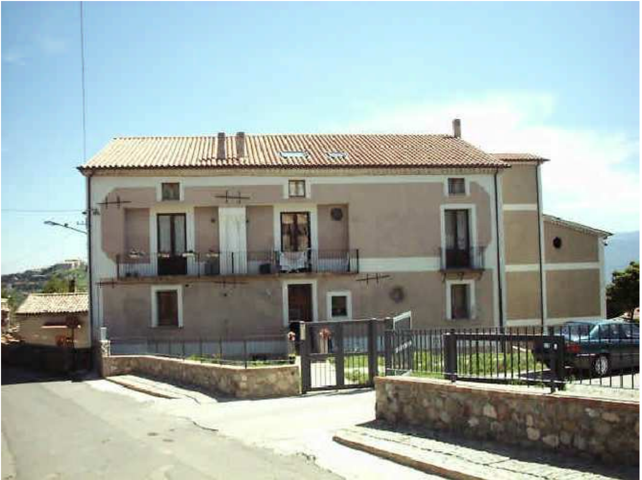
palazzo Conforti (via Assunta),
