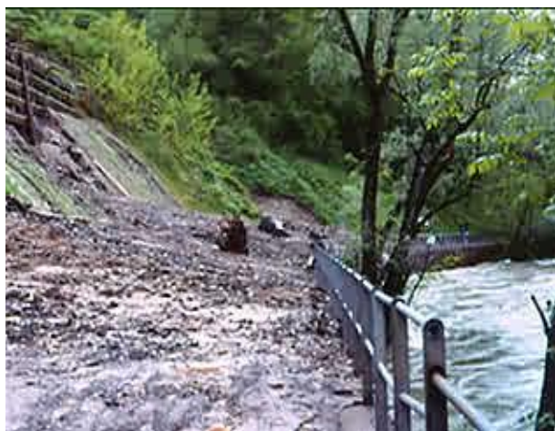
Foto – Frana di Cremenaga e crollo della Sp61 in seguito all'erosione della sponda per opera del fiume Tresa in piena – maggio-novembre 2002
