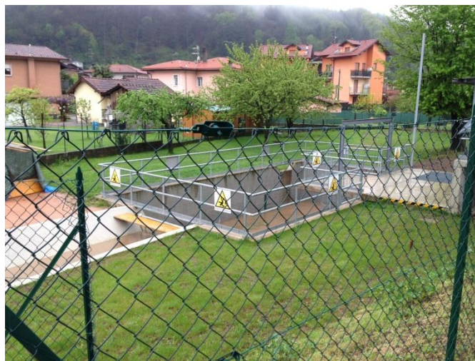
Foto: Canale scolmatore e Vasca Volano poste in località Premaggio (Germignaga e Luino) al fine di contenere le portate del fosso Mondiscia
