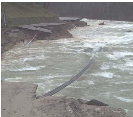
Foto – Frana di Cremenaga e crollo della Sp61 in seguito all'erosione della sponda per opera del fiume Tresa in piena – maggio-novembre 2002
